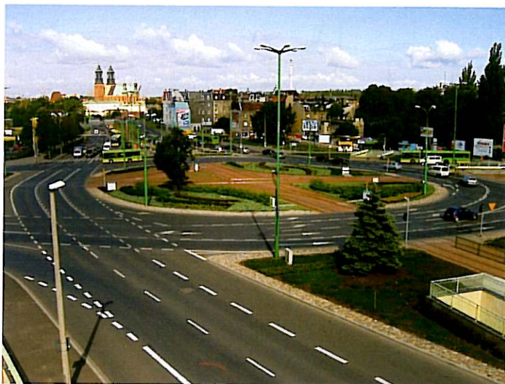
Przykład prawidłowo oznakowanego skrzyżowania rozszerzonego
