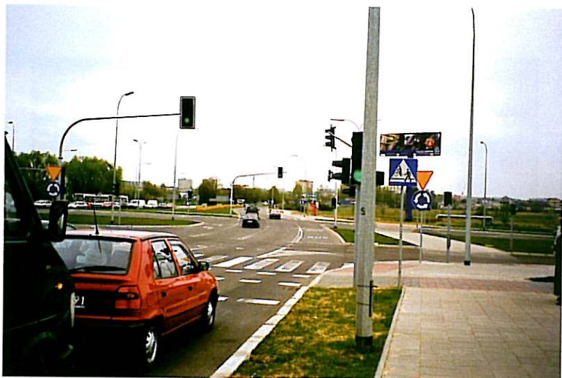
Pas dla autobusów wydzielony na skrzyżowaniu rozszerzonym, na przedłużeniu pasa ruchu wydzielonego dla skrętu w prawo
